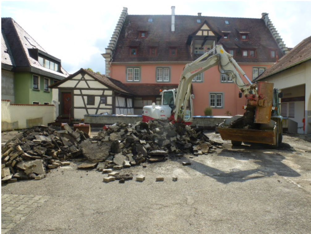
Während der Sanierung
