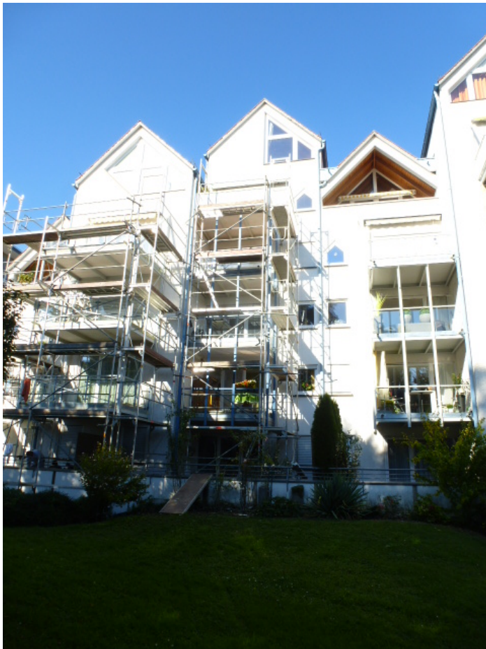
Während der Sanierung
